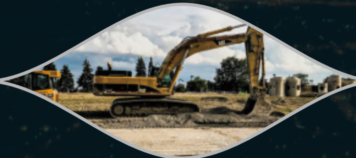
路桥施工场景
